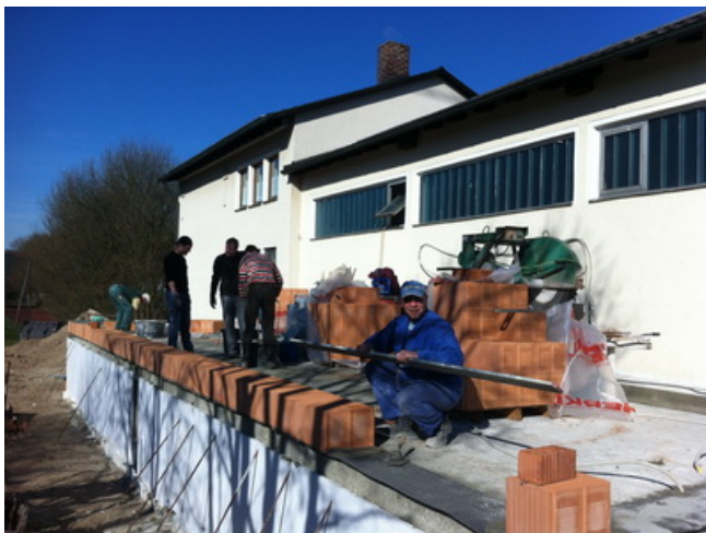
12.04.2013 Betonieren der Kellerdecke 13.04.2013 Ausschalen der Kellerdecke 15.04.2013 Mauern der Außenwände
