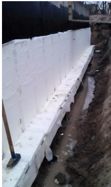
06.04.2013 Grundanstrich angebracht, Wände isoliert und Baugrube verfüllt
