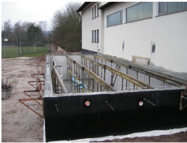
11.04.2013 Verlegen der Fertigdecke, einschalen der Kellerdecke und einbringen der Armierungseisen
