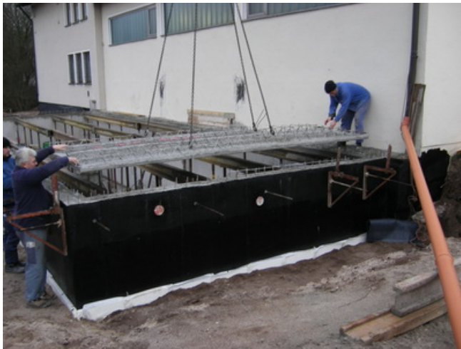
11.04.2013 Verlegen der Fertigdecke, einschalen der Kellerdecke und einbringen der Armierungseisen
