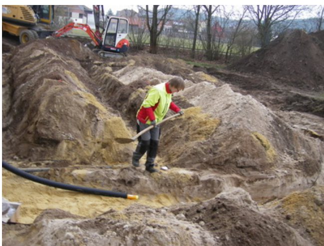
11.03.2013 Alte Gasleitung ausbauen, neue Erdgasleitung verlegen mit Stadtwerke und Fa. Wünschmann. Graben verfüllen.
