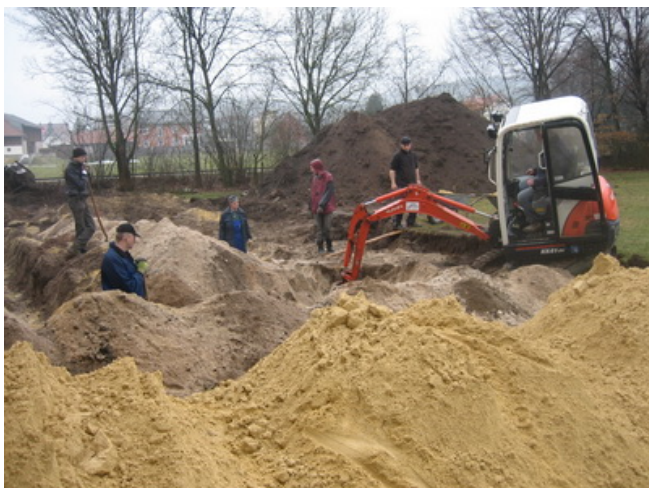
11.03.2013 Alte Gasleitung ausbauen, neue Erdgasleitung verlegen mit Stadtwerke und Fa. Wünschmann. Graben verfüllen.
