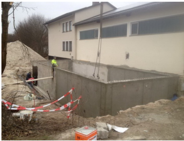
06.04.2013 Grundanstrich angebracht, Wände isoliert und Baugrube verfüllt
