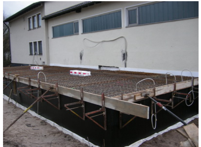
11.04.2013 Verlegen der Fertigdecke, einschalen der Kellerdecke und einbringen der Armierungseisen
