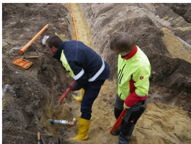
11.03.2013 Alte Gasleitung ausbauen, neue Erdgasleitung verlegen mit Stadtwerke und Fa. Wünschmann. Graben verfüllen.
